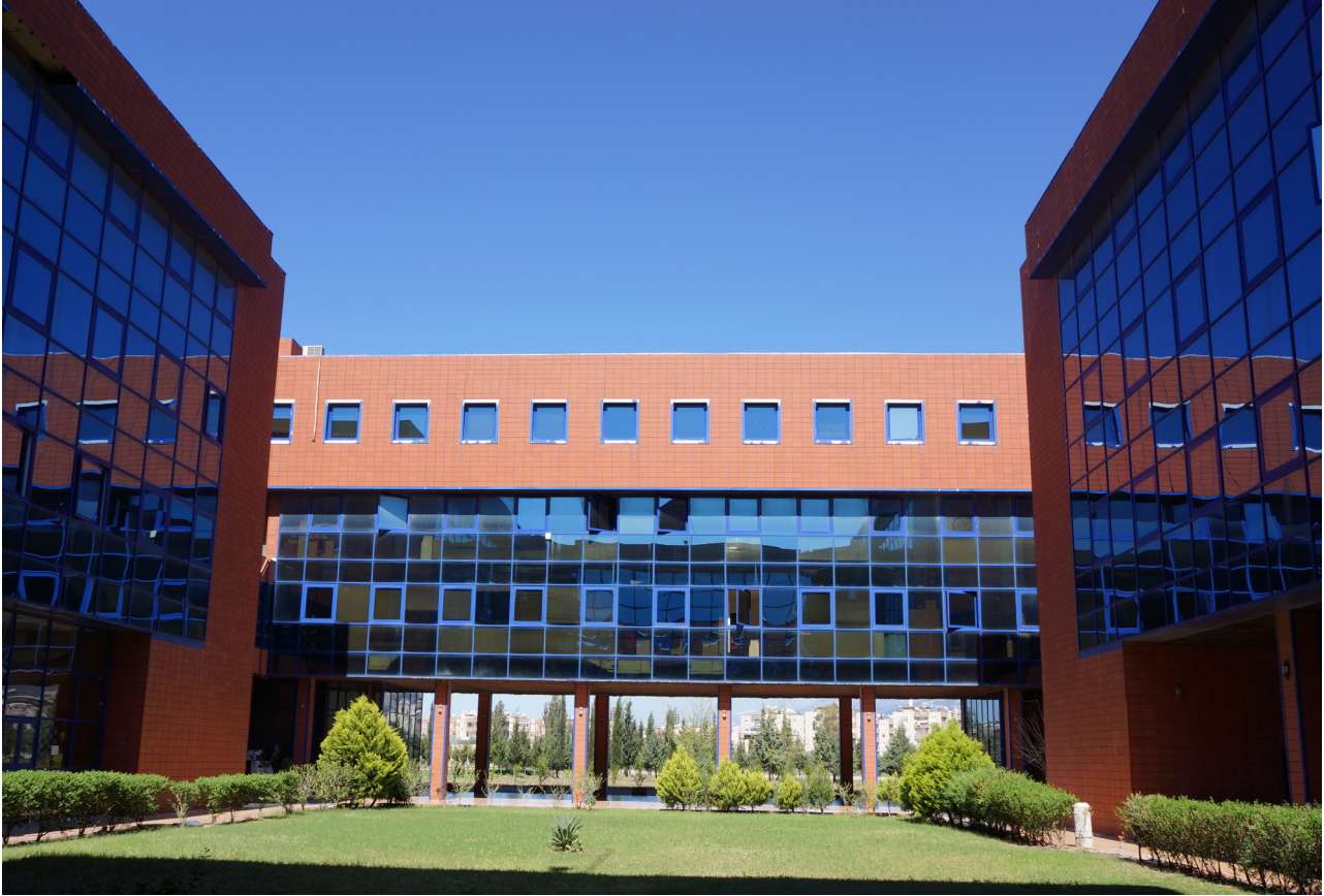
Resim 8: Mühendislik ve Doğa Bilimleri Fakültesi Binası
