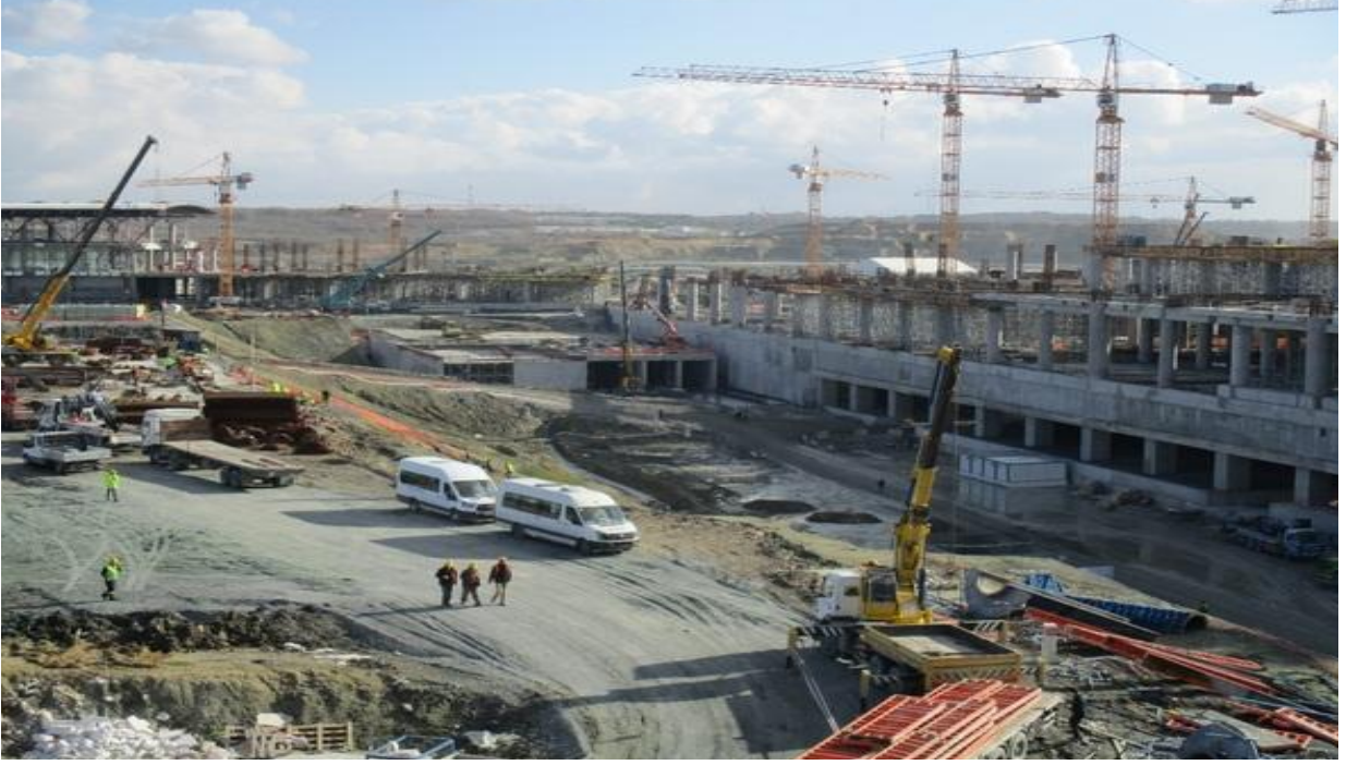
Resim 46: İnşaat Mühendisliği Bölüm Öğrencilerinin 3'üncü Hava Limanına Teknik Gezi
