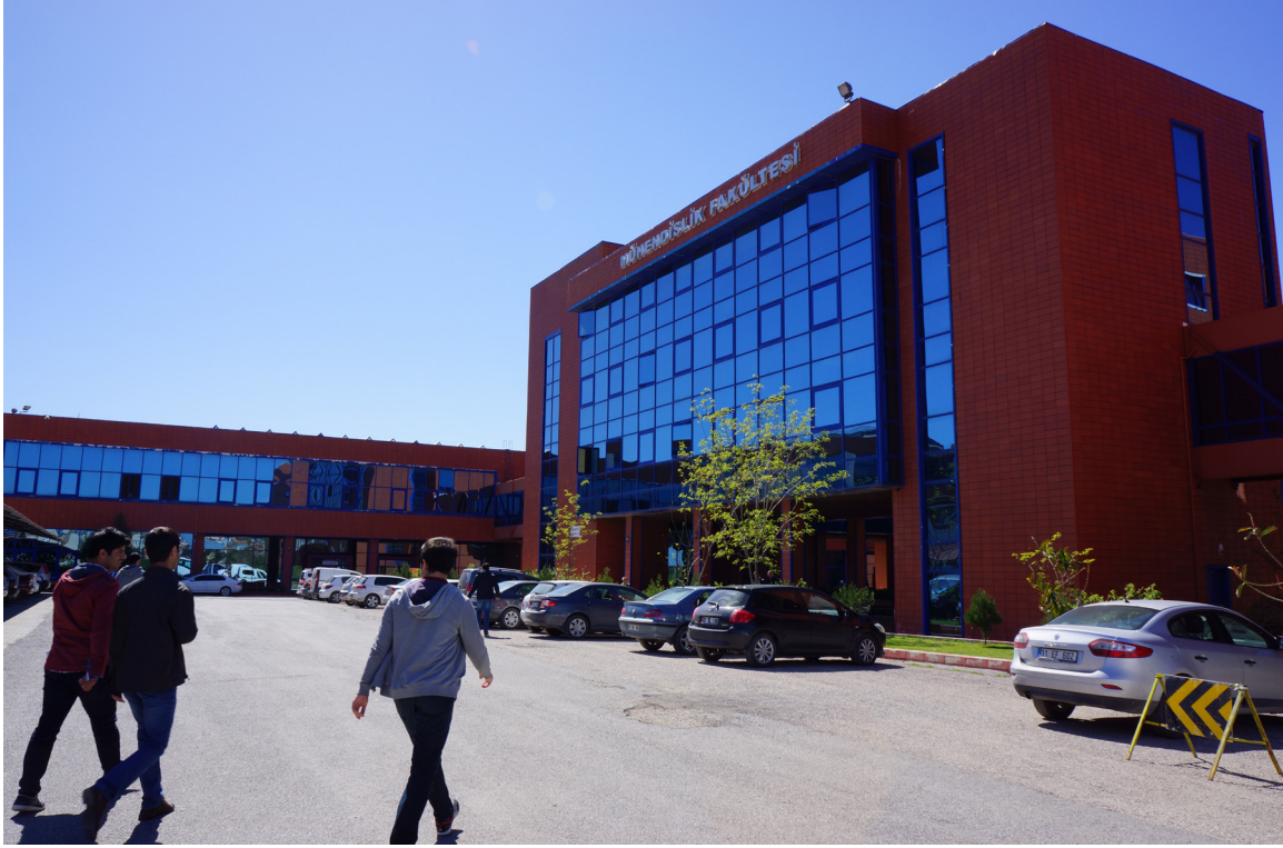
Resim 9: Mühendislik ve Doğa Bilimleri Fakültesi Binası
