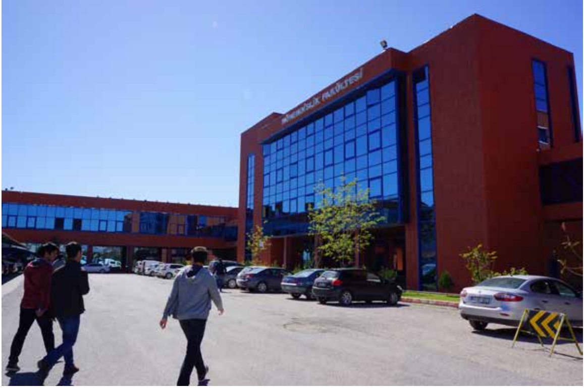
Resim 6: Mühendislik ve Doğa Bilimleri Fakültesi Binası
