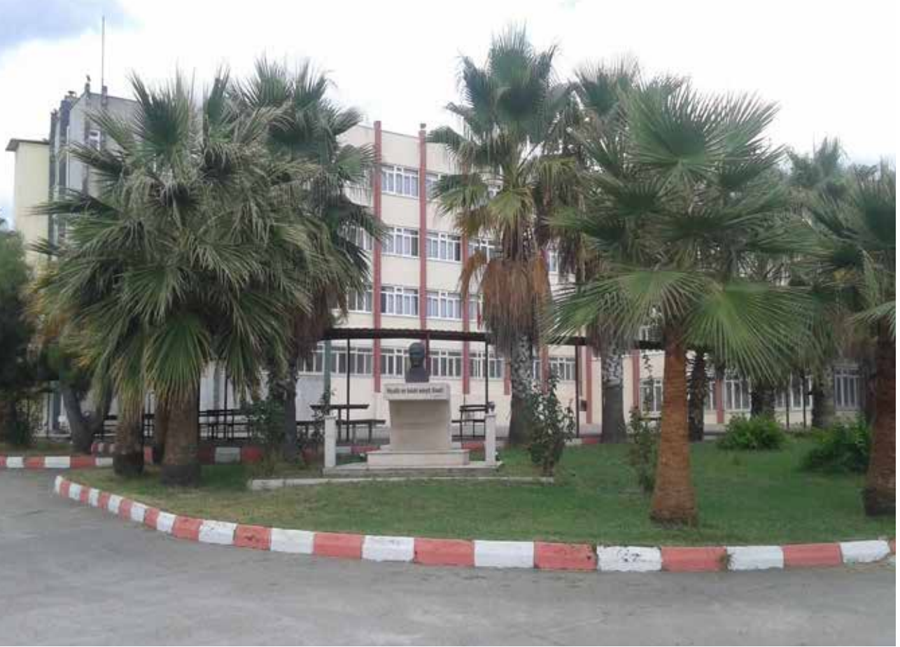
Resim 11: Dörtyol Meslek Yüksekokulu Eğitim Binası
